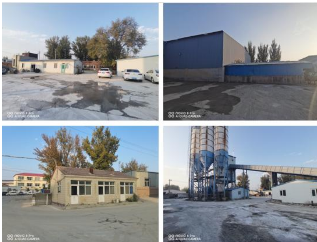
图 3-4 项目厂区现场照片
