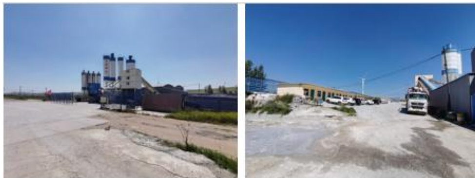
图 3-4 项目厂区现场照片
